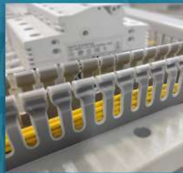
รูปแบบการใช้งานรางวดยดักส์ในตู้คอนโทรล
