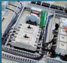
รูปแบบการใช้งานรางวดยดักส์ในตู้คอนโทรล
