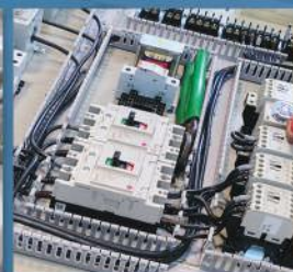
รูปแบบการใช้งานราวสายไฟในตู้คอนโทรล
