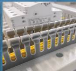
รูปแบบการใช้งานรางว้ายดักส์ในตู้คอนโทรล
