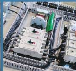
รูปแบบการใช้งานรางว้ายดักส์ในตู้คอนโทรล
